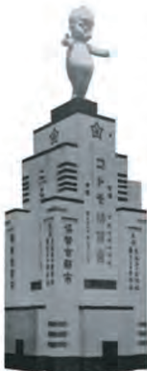
大正時代のキューピー塔
